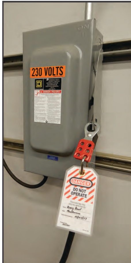
Figura 2-3: Ejemplo de un mecanismo de Bloqueo/Etiquetado en un panel de fuente de alimentación
